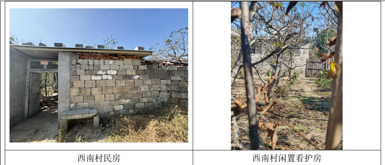
图 6-1 探伤室区域、周围保护目标现状图（拍摄于 2024 年 10 月）
