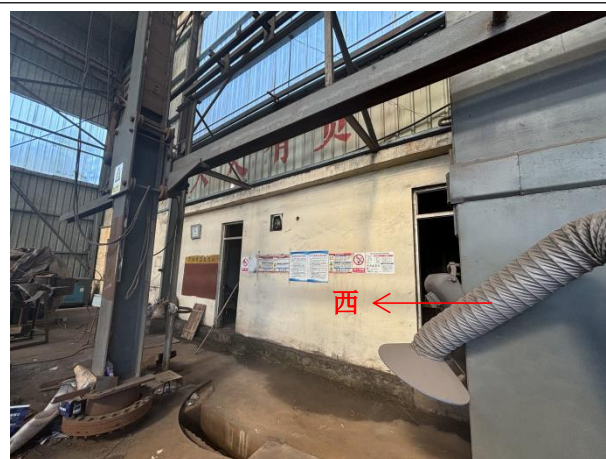
探伤室西侧区域现状
