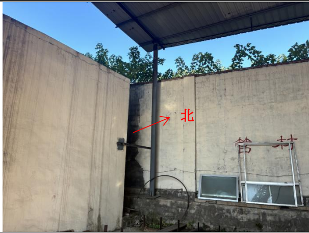
探伤室北侧区域现状
