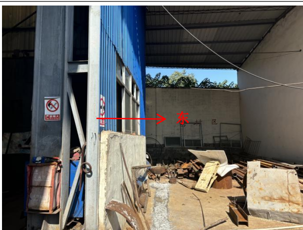
探伤室东侧区域现状
