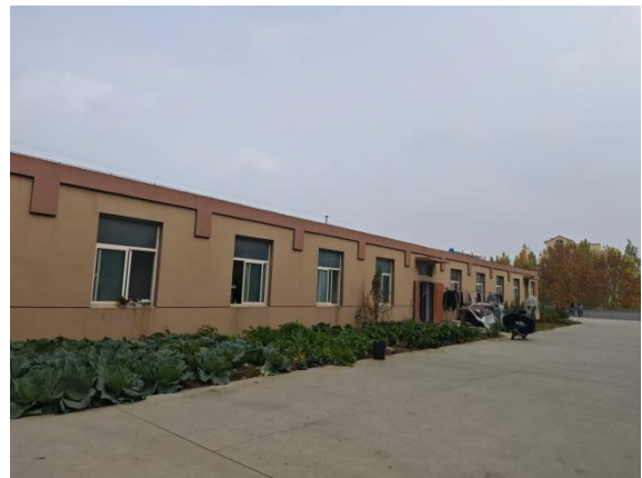
车间北侧办公楼
