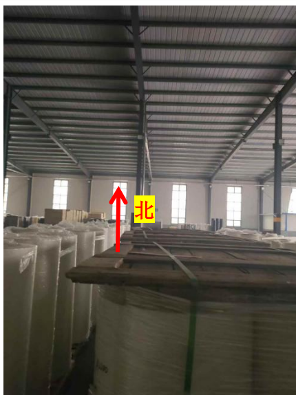
加速器拟安装区域北侧现状
