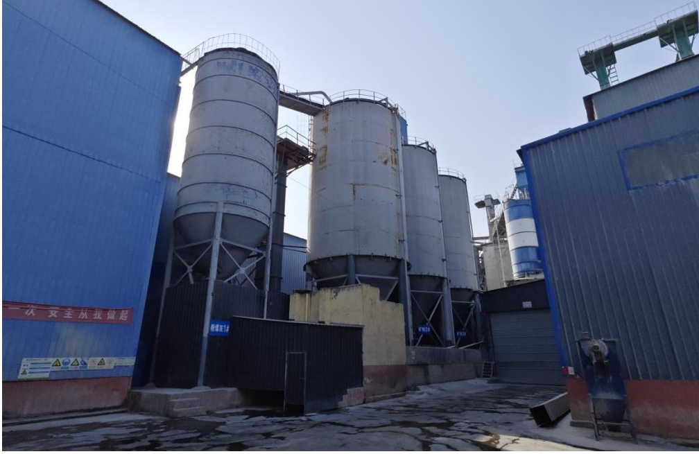
厂区储罐环境
