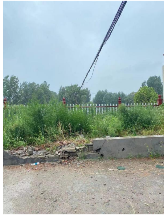
主楼西侧现状
