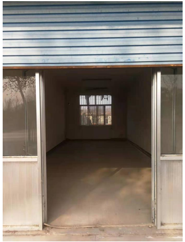
危废暂存间拟建区域现状
