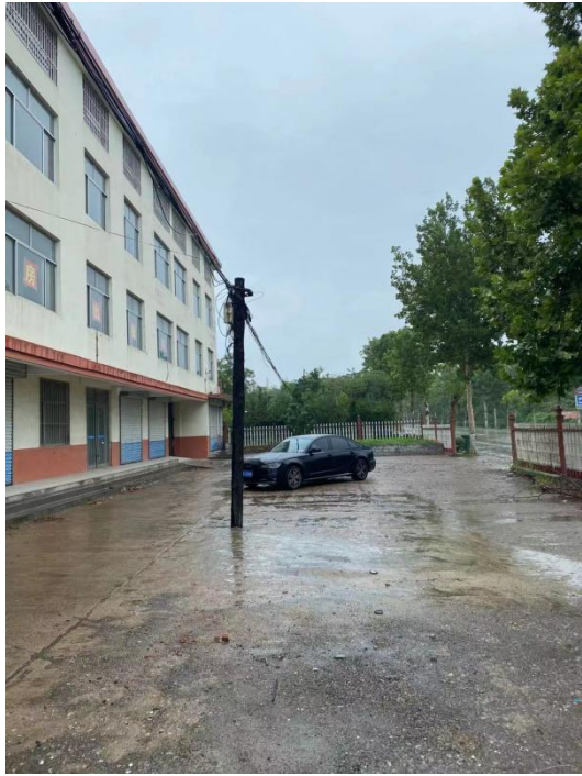
主楼南侧现状(厂内空地)
