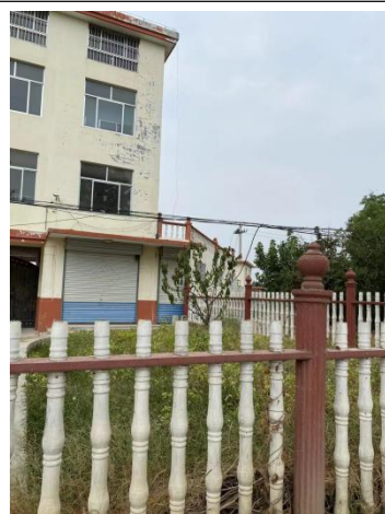
主楼东侧现状
