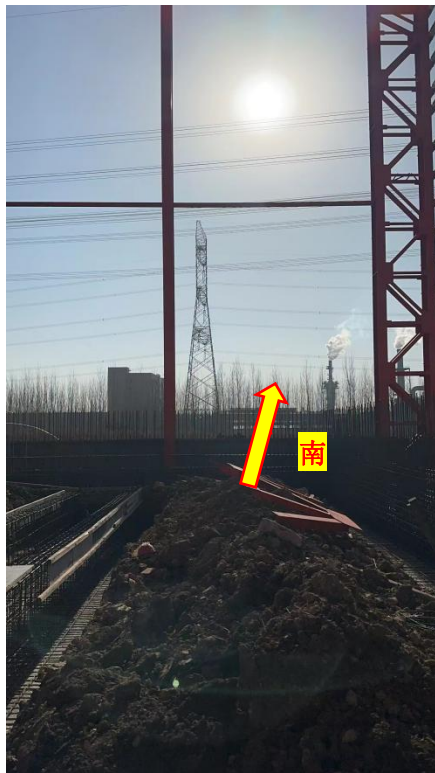
拟建探伤室南侧区域现状
