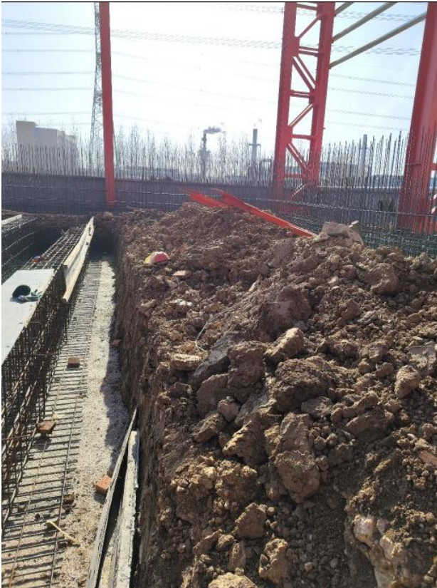
拟建探伤室内现状
